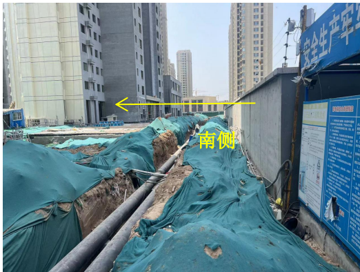
图 4-3 变电站南侧翰林天悦小区（在建）
