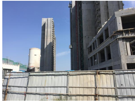
变电站东侧翰林天悦住宅楼
