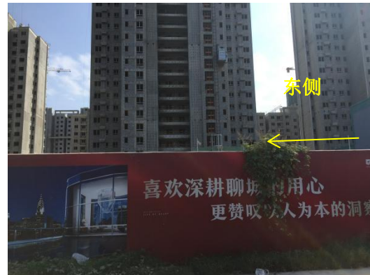
图 4-4 变电站东侧翰林天悦小区（在建）
