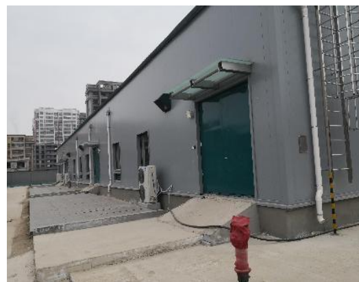
图 4-11 10kV 配电装置室
