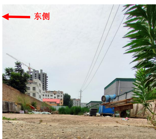
图 4-3 站址东侧—新兴建安小区
