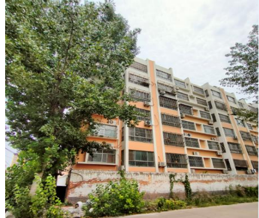
2. 新建建安小区（变电站东侧）
