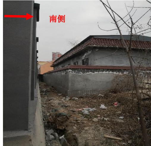
图 4-4 站址南侧-田庄村房屋
