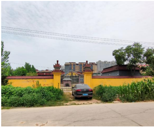
1.田庄村房屋（变电站南侧）
