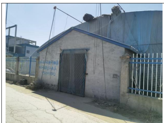
变电站西侧大棚看护房
